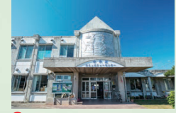
9 中央区コミュニティセンター Chuo District Community Center
