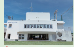
8 北区コミュニティセンター Kita District Community Center
